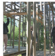
Fig. démontage de l'armant de la fontaine
