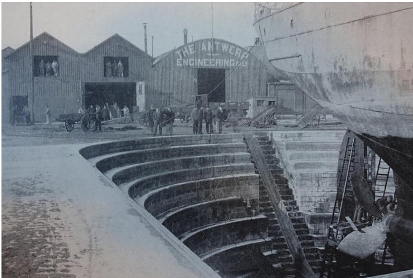
REFERENCE, Dry dock 4, Antwerp. Archief Gemeentelijk Havenbedrijf
