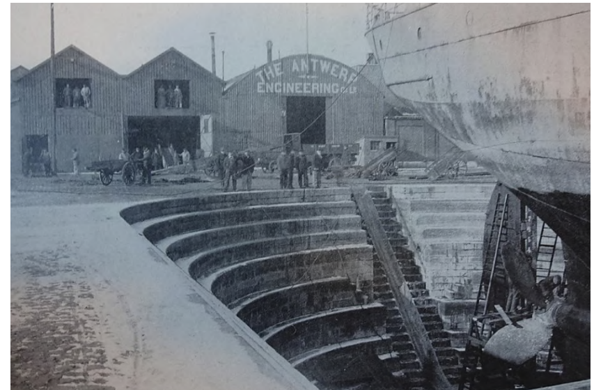
REFERENCE, Dry dock 4, Antwerp. Archief Gemeentelijk Havenbedrijf
